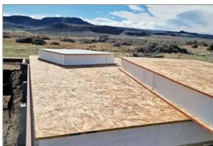
Los paneles SIP, en la imagen, que se utilizan para la construcción de viviendas privadas y sociales, entre otros.
