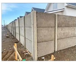
La Constructora Safa ha incorporado 40 toneladas de plástico reciclado a sus elementos de hormigón. En la foto, las panderetas prefabricadas.
